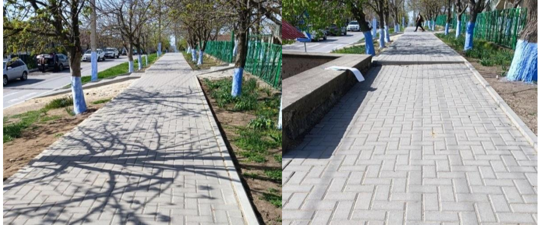
(Фотографии сделаны контролерами СПГ в ходе проведенного визуального осмотра)
