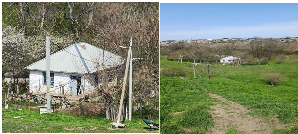
(Фотографии сделаны контролерами СПГ в ходе проведенного визуального осмотра)
